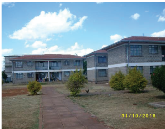
Flat done under Moody (Kamiti)
